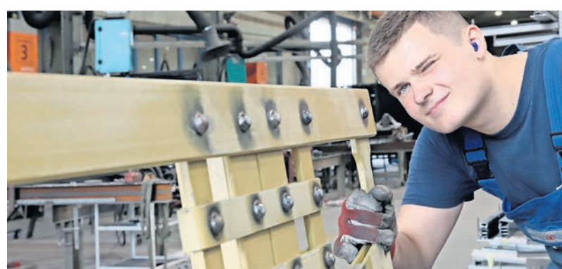
Fabian Unterseher ist im vierten Ausbildungsjahr und baut mit alten Metallbautechniken Geländerteile für die Plauer Brücke nach Originalvorlagen.
