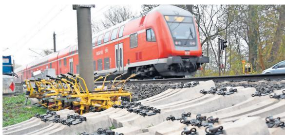
Die Schwellen, Schotter und die Arbeitsgeräte liegen schon bereit für die Reparaturarbeiten am Gleis in Höhe der Planebrücke. FOTO: RÜDIGER BÖHME
